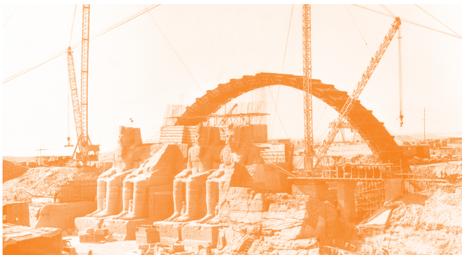
L'ultima fase di rimontaggio di una delle statue di Ramses II
