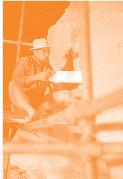
La fase finale del taglio eseguito mediante seghe a mano
