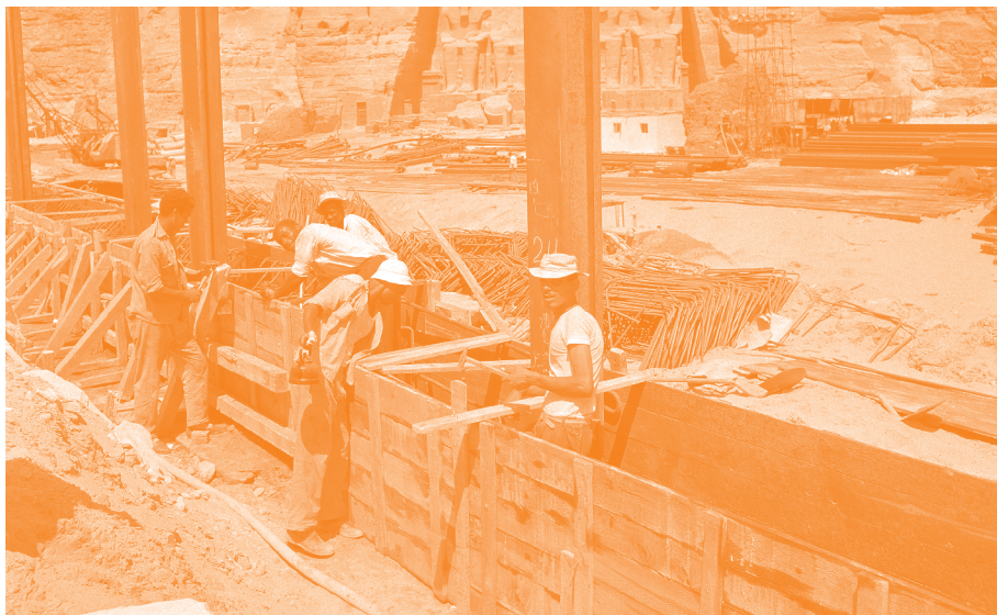
Il Tempio Maggiore e la preparazione del cofferdam
