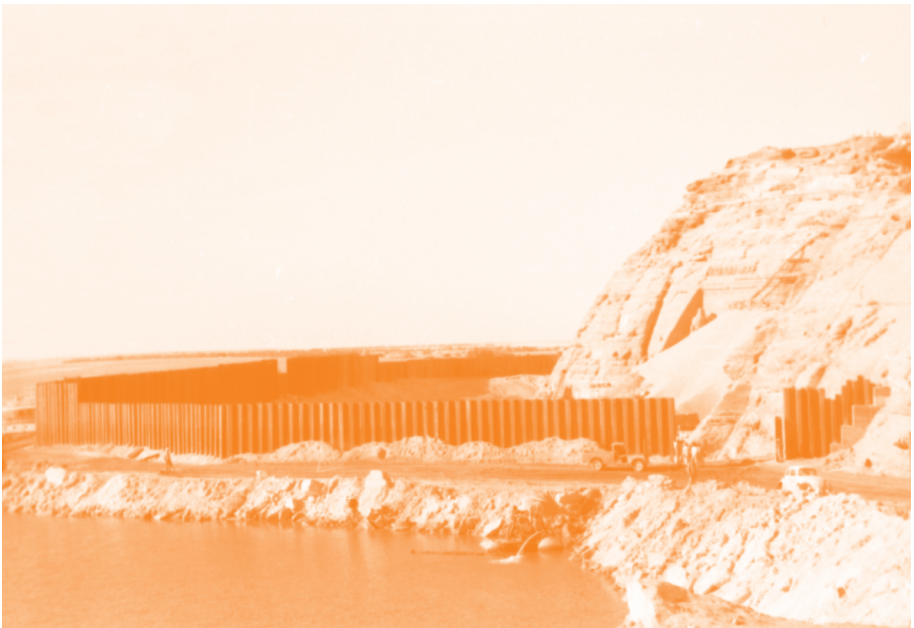
La diga di sbarramento o cofferdam nella zona del Tempio Maggiore
