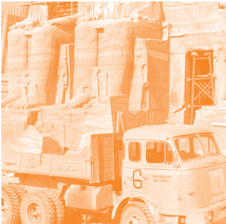
Il Tempio Maggiore, fase del trasporto dei blocchi durante la ricostruzione della facciata
