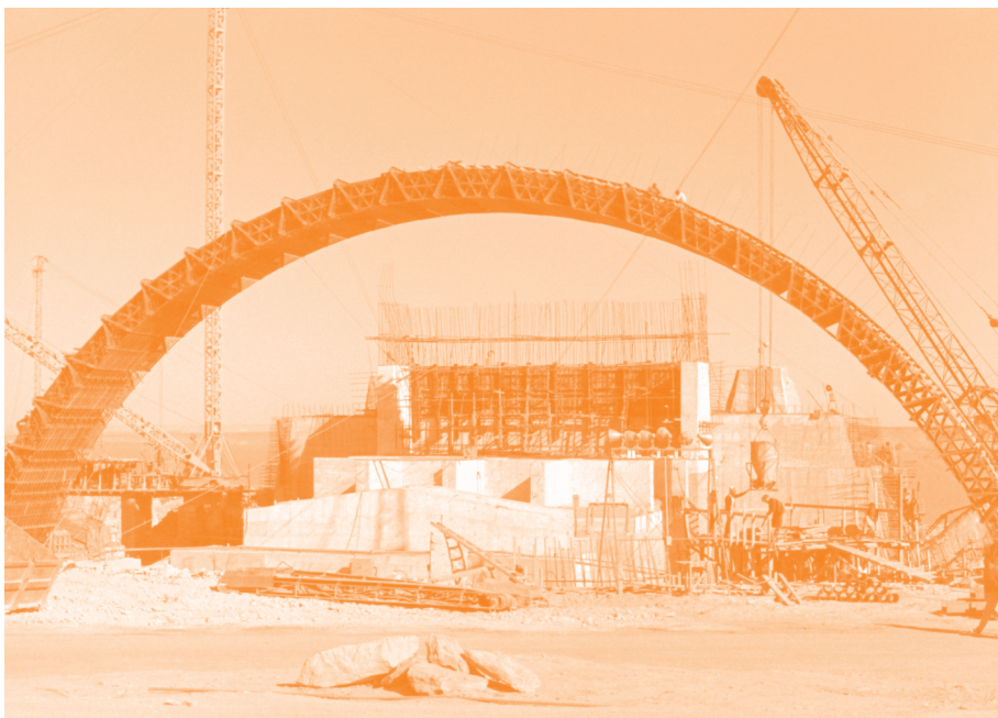
Il Tempio Maggiore, assemblaggio della grande centina per la cupola che sosterrà la collina artificiale
