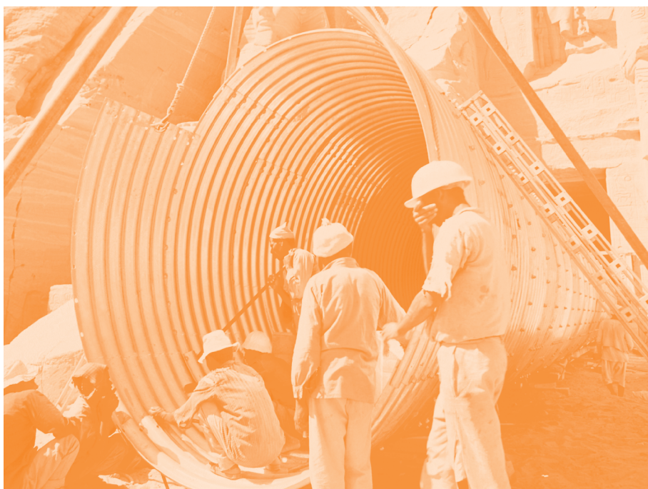
Il Tempio Maggiore, il tunnel di acciaio per consentire l'accesso all'interno dopo la copertura con la sabbia
