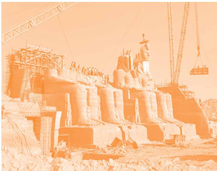
Il Tempio Maggiore, riposizionamento di uno dei volti di Ramses II
