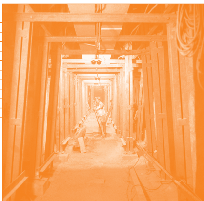
Il Tempio Maggiore, sostegni di pareti e colonne
